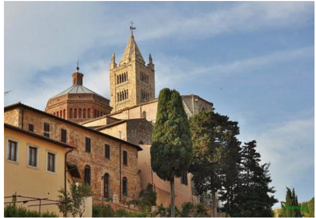
Blick auf die Rückseite des Domes
