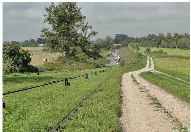
Das Schiff hielt zwischen den aus dem Wasser ragenden Barrieren. Dann bewegten sich die großen Antriebsräder und aus dem Wasser erhob sich eine Plattform, auf welcher das Schiff stand, und langsam bergauf gezogen wurde.
